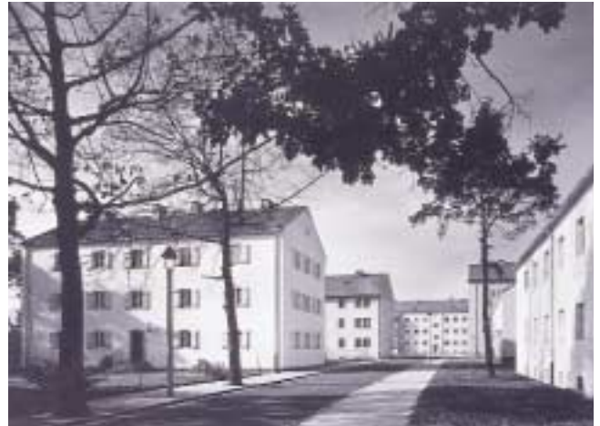
Geschosswohnbau im Rahmen der Deutschen Bau-Ausstellung 1949 in Nürnberg: wirtschaftliche Haustypen bei äußerster Sparsamkeit an Material und Raum
