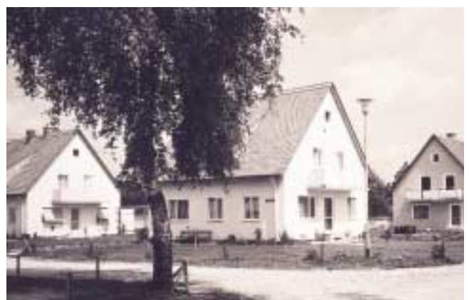
Waldkraiburg, Kaufeigenheime, 1960: beeindruckende Aufbauleistungen auch im Eigenheimbau
