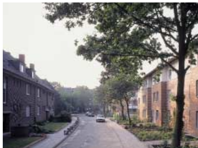
Duisburg-Hamborn: Anfang der 30er Jahre errichtete und Mitte der 90er Jahre nachverdichtete Siedlung (Foto: Jens Willebrand, Köln)
