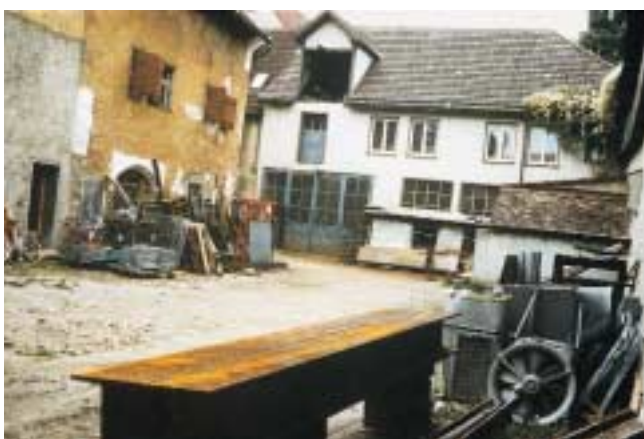
Stadterneuerung in Wangen im Allgäu: Sanierung Weberzunfthaus und Zunfthaus mit Stadtmauer, Auslagerung einer Schlosserei
